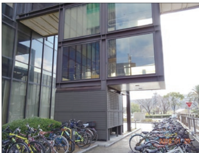
図9. 今後も使用される2階部分の喫煙室
